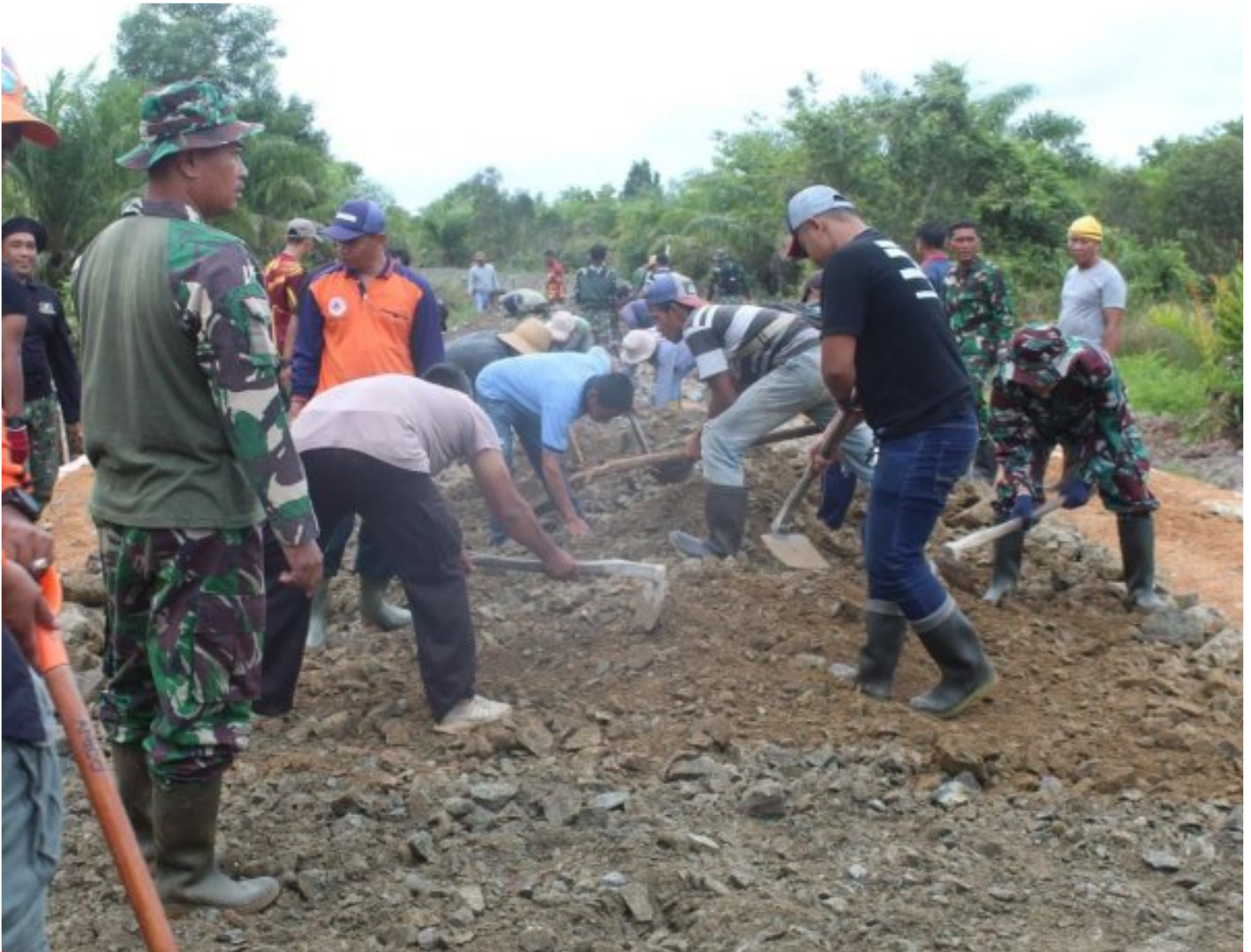
TMMD Ke 117 Desa Telaga Langsung, Bangkitkan Jiwa Gotong Royong Warga
