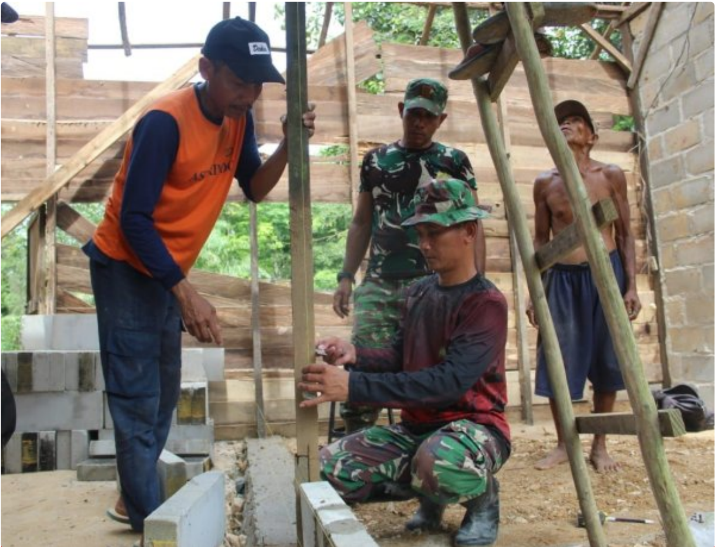
Sasaran Bedah Rumah, Sudah Tahap Pemasangan Dinding
