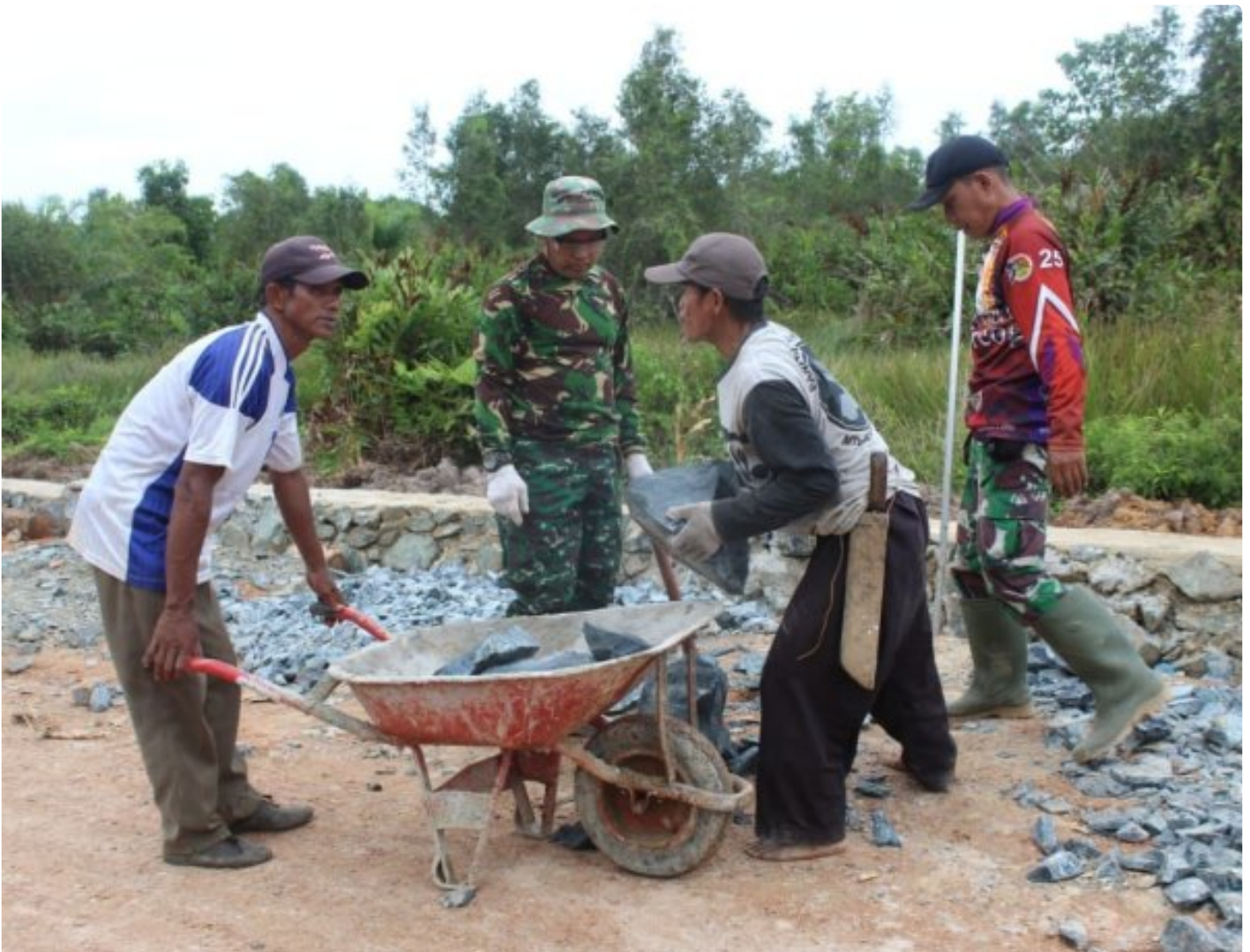
Personel Satgas TMMDKe - 117, Kerjakan Siring Jalan
