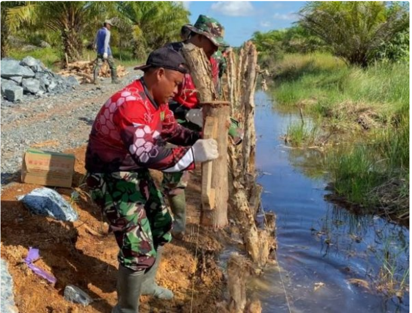
"Kayu Galam" Potensial Untuk Landasan Pemasangan Pondasi
