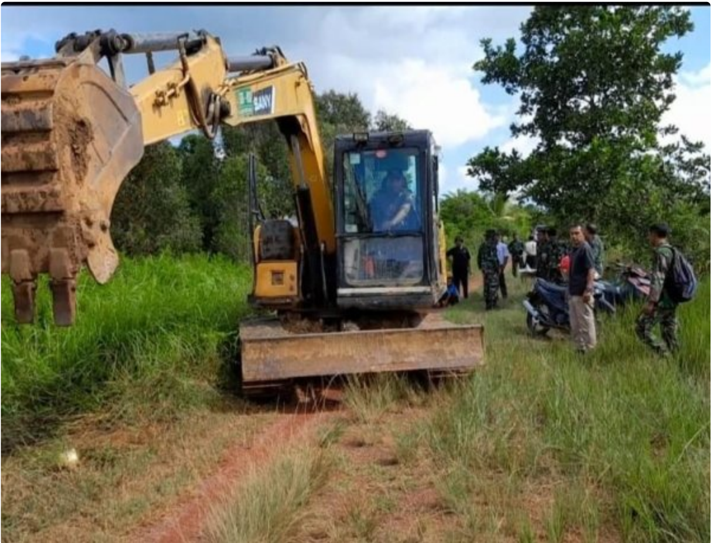
Dandim 1009/Tla, Turunkan Excavator Di Lokasi TMMD
